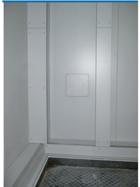
Wand mit umkleideter Tragstruktur und Auffangwanne
