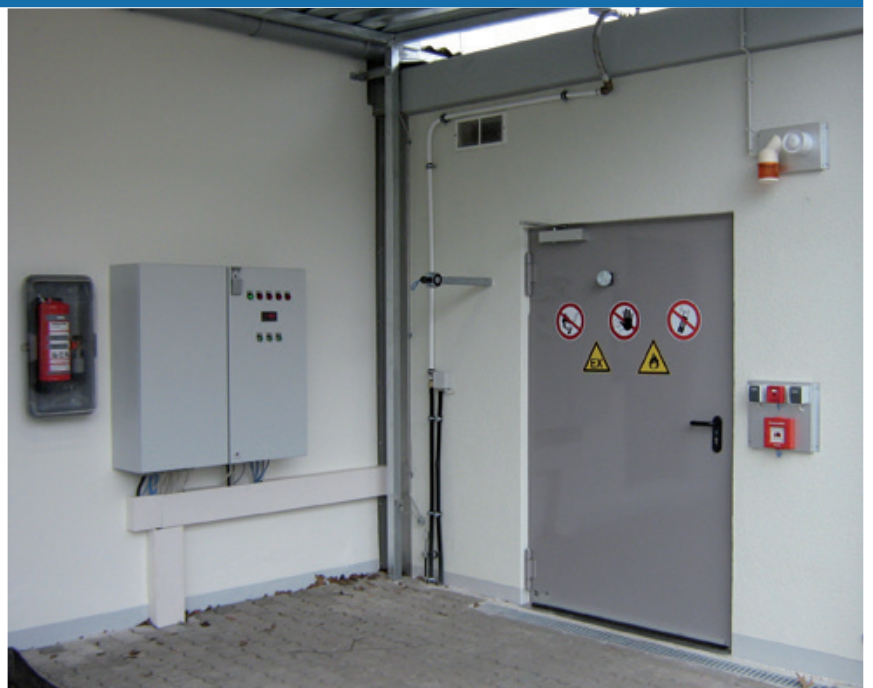
SAFEBOX-Betonmodule, rechts mit Zugangstür, Personenüberwachungsanzeige rechts oben und Elektroverteiler
