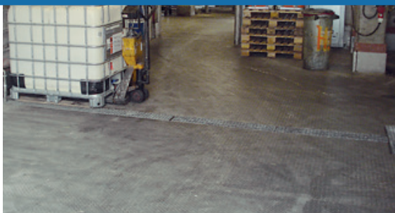
Edelstahlauskleidung im rauen Betrieb
