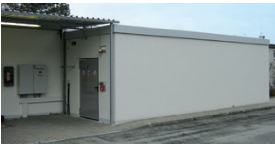
SAFEBOX-Betonmodule, rechts mit Zugangstür, Personenüberwachungsanzeige rechts oben und Elektroverteiler
