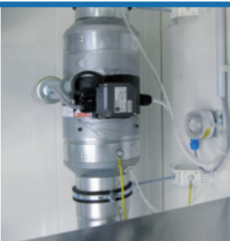
Abluftventilator ex-geschützt
