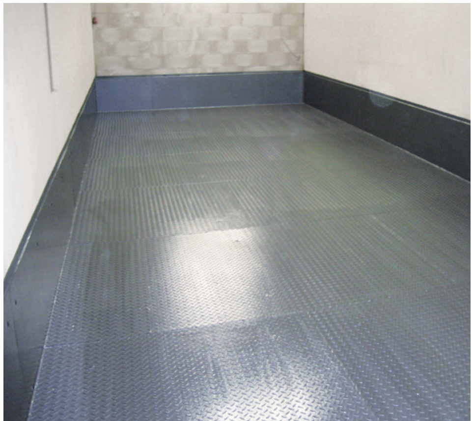
Mit Auffangeinrichtung ... und integrierter Löschwasserrückhaltung
