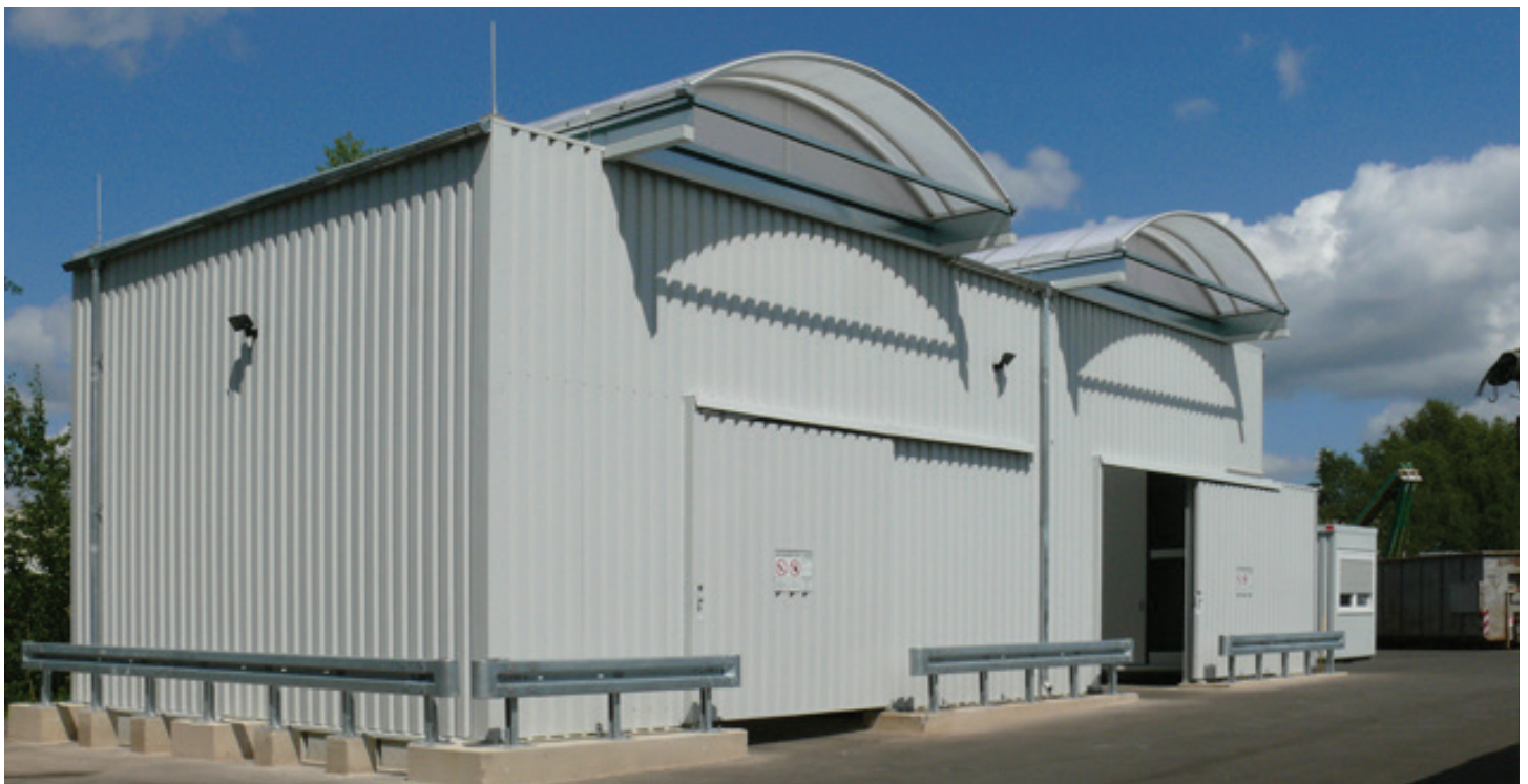
Regalcontaineranlage mit Dachlichtband und zwei Fahrgängen
