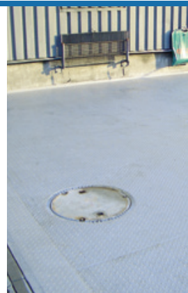
Einbindung eines Leichtstoffabscheiders
